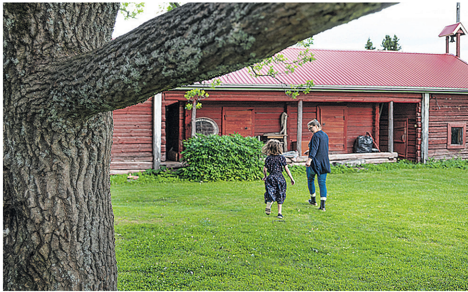
Isoon aittaan kunnostetaan perheelle väliaikaiset asuintilat myöhemmin alkavan päärakennuksen remontin ajaksi. Sauna sijaitsee aitan päädyssä, kuvassa oikealla.
