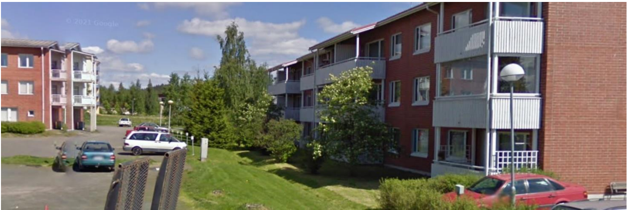
Kuva 19: Kortteleiden 136 ja 137 välissä on asemakaavassa yleiselle jalankululle varattu rakennuskaavatiealue. Reittiä ei ole rakennettu, sillä kasvaa puita ja pensaita.
