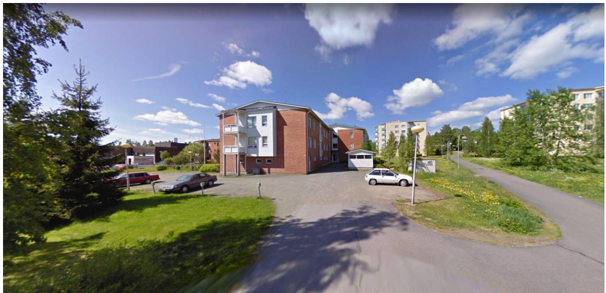
Kuva 5 Sipiläntie 3, purettava rakennus. (@Google 2009)
